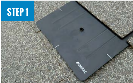
INSTALL FLASHKIT PRO FLASHING
